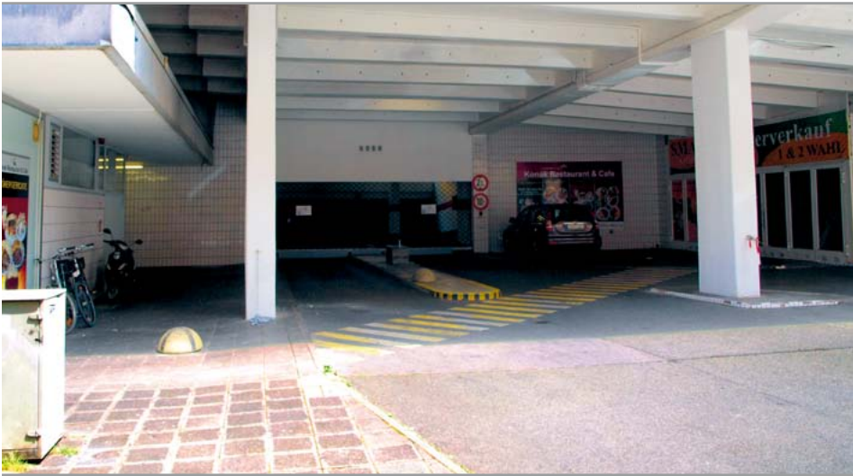
Abbildung 40: Parkhaus, geeignet als stationäres Mikro-Depot (Einfahrthöhe für LKW)
